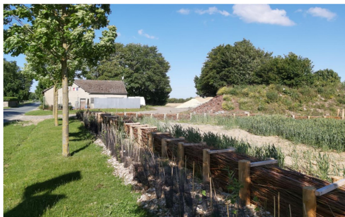
Figure 35 : Exemple de haie fascine
