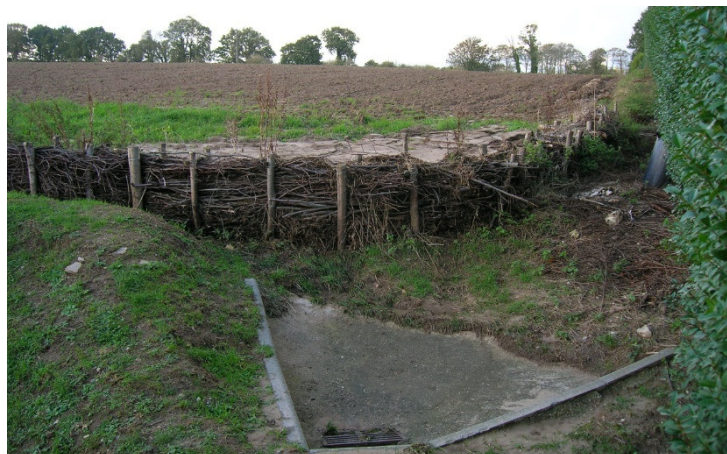
Figure 32 : Exemple de fascine d'angle
